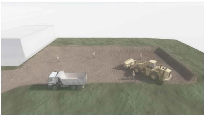
1 SCAVO GENERALE DI SBANCAMENTO
