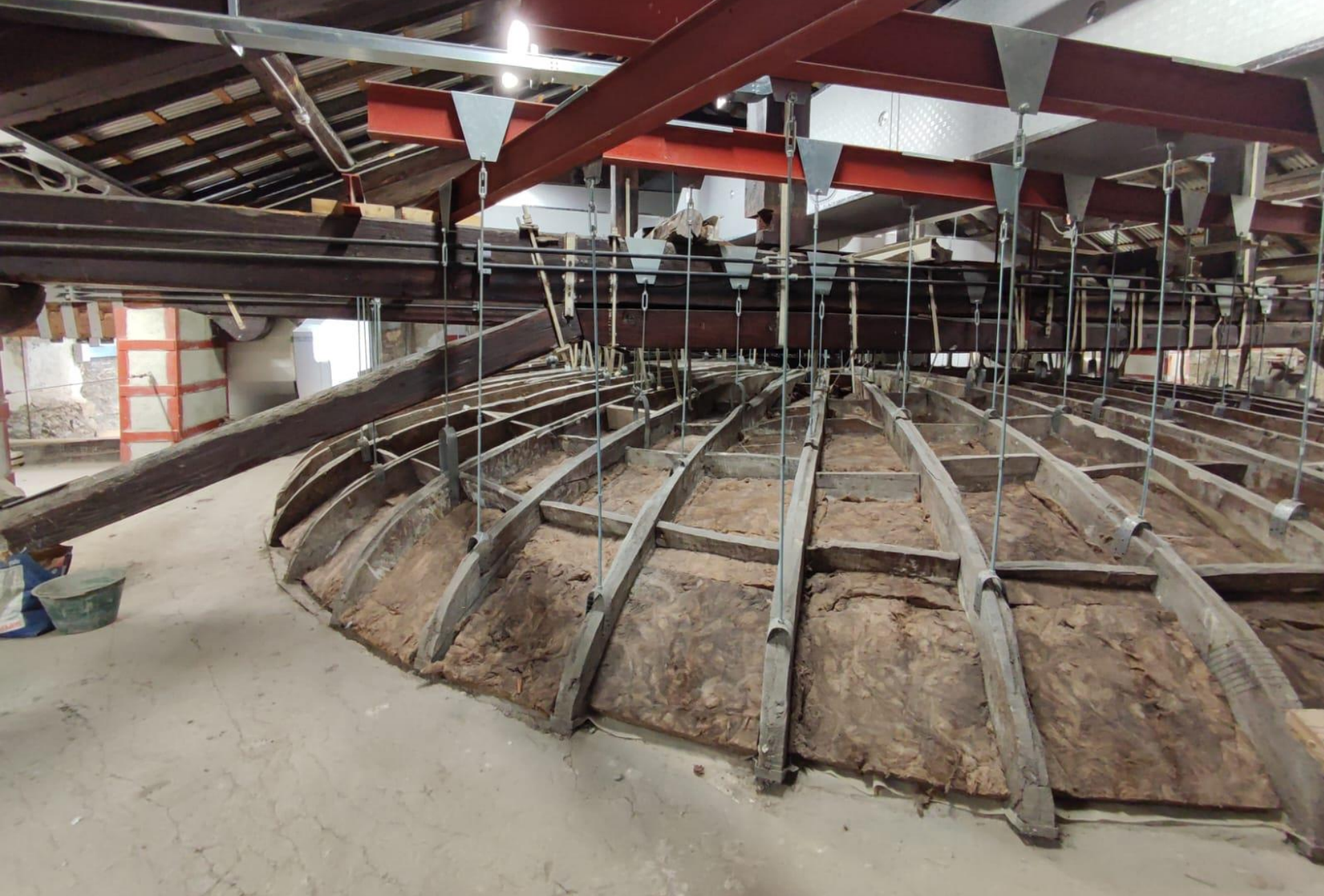
Teatro della Società – estradosso consolidamento strutturale
