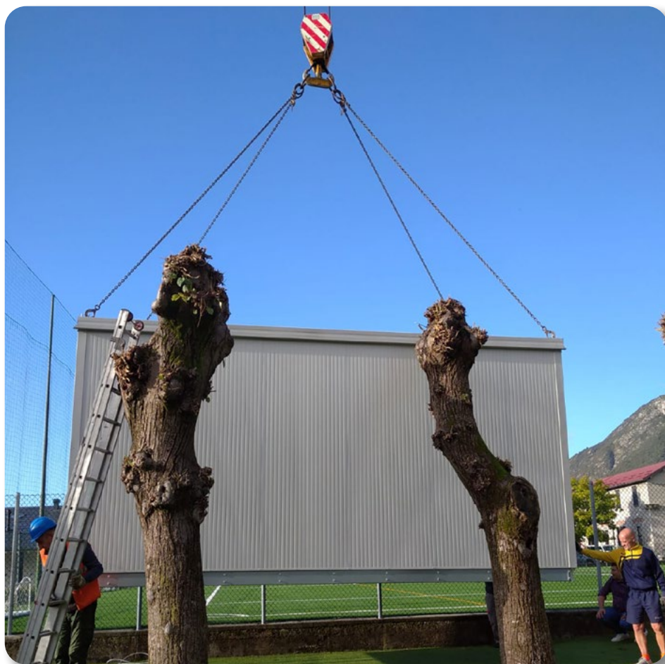
Posizionamento della casetta container.
