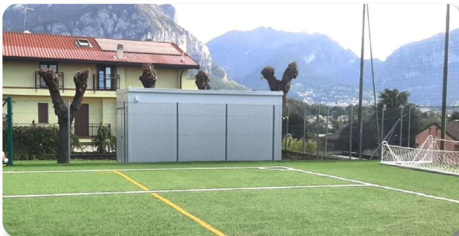
Casetta container che viene utilizzata per mettere tutte le attrezzature per gli allenamenti.
