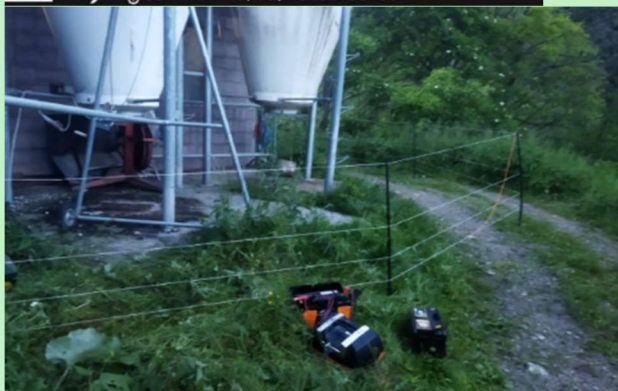
Fig. B8.2 (in alto) – Recinzione elettrificata installata a protezione del silo.
